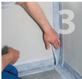
Butilo juosta klijuojama ant švaraus ir sauso paviršiaus, taip pat galima klijuoti ir ant šviežiai padengtos Keramix A+X mastikos.
