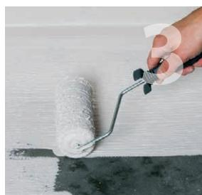
Paviršius padengiamas hidroizoliacine mastika Keramix A+X ir paliekamas džiūti ne trumpiau kaip 1 valandą (kol pasikeis spalva).
