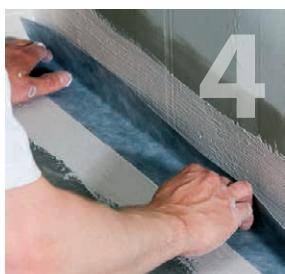
Patalpose, kuriose nejrengtas pastovus šildymas, prieš tepant hidroizoliacinių sluoksnų, pagrindas sudrékinamas vandeniu (šildomose patalpose naudojamas gruntas). Po to pagrindui leidžiama šiek tiek pradžiūti, kol išnyksta blizgesys. Keramix A+X komponentai sumaišomi santykiu 1:1. Kampusose ir įvairių medžiagų sandūry vietose, ant švaraus ir sauso paviršiaus arba ant šviežiai padengtos Keramix A+X mastikos, prilipdoma Butilo juosta.
