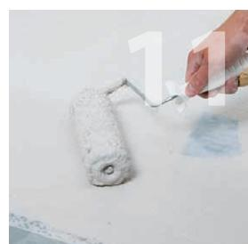
Paviršius padengiamas hidroizoliacine mastika Keramix A+X ir paliekamas džiuti ne trumpiau kaip 1 valandą (kol pasikeis spalva).
