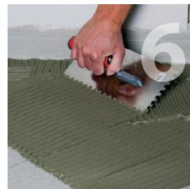
Keramix A+X komponentai sumaišomi santykiu 1:1. Kampuose ir skirtingų medžiagų sandūrų vietose, ant švaraus ir sauso paviršiaus arba ant šviežiai padengtos Keramix A+X mastikos, prilipdoma Butilo juosta.
