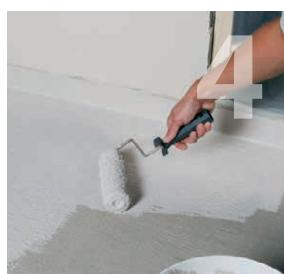
Paviršius padengiamas antruoju hidroizoliaci-nės mastikos Keramix A+X sluoksnii ir paliekamas džiūti ne trumpiau kaip 1,5 valandos (kol pasikeis spalva). Bendros medžiagos sąnaudos – ne mažiau kaip 1,5 kg/m<sup>2</sup>, kai sluoksnio storis 0,8 mm.
