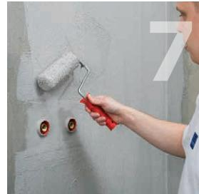
Paviršius padengiamas antruoju Keramix A+X hidroizoliacijos sluoksniu ir paliekamas džiuti ne trumpiau kaip 1,5 valandos (kol pasikeis spalva). Bendros mastikos sąnaudos – ne mažiau kaip 1,5 kg/m<sup>2</sup>, kai sluoksnio storis 0,8 mm.
