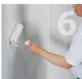
Paviršius padengiamas Keramix A+X mastika ir paliekamas džiuti ne trumpiau kaip 1 valandą (kol pasikeis spalva).
